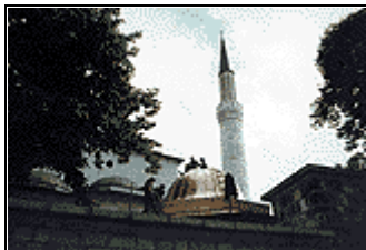
Sarajewo - trwają prace przy remoncie meczetu Fot. Jan Piekło
